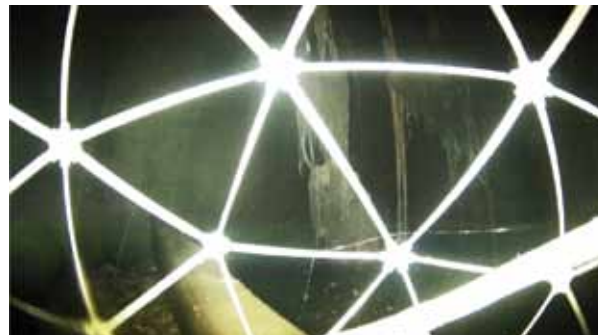
FIGURA 6. Fondo del pozo de bombeo. Se aprecia que no hay residuos flotantes o sedimentación importante. El principal problema detectado es la presencia de toallitas.
