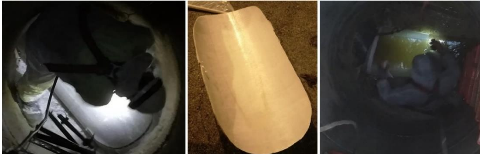
ESQUEMA BÁSICO DEL FINAL DE UNA REHABILITACIÓN DE COLECTOR DE SANEAMIENTO, SIN OBRA CIVIL, A TRAVÉS DE LA INSERCIÓN, EXPANSIÓN Y CURADO DE MANGA DE FIELTRO IMPREGNADA DE RESINA, ALCANZANDO SU RESISTENCIA DE CÁLCULO TRAS POLIMERIZACIÓN DE ESTA
