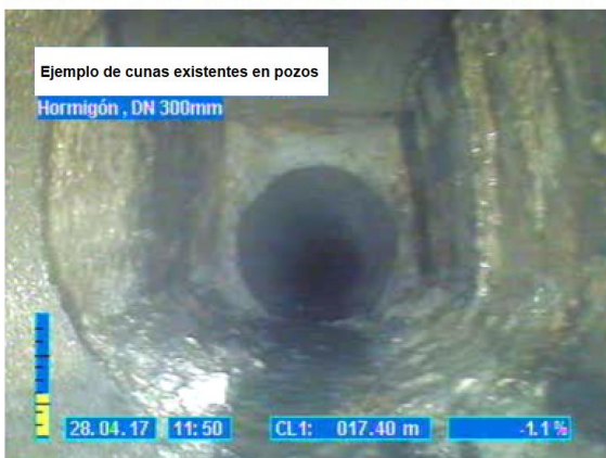
CONSOLIDACIÓN DE NUEVAS CUNAS EN LOS POZOS DE REGISTRO EXISTENTES, MEDIANTE RECORTE DE LA MANGA CONTINUA INTRODUCIDA Y POLIMERIZADA
