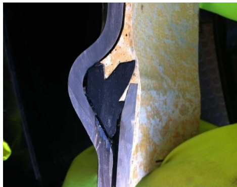
CONSOLIDACIÓN DE NUEVAS CUNAS EN LOS POZOS DE REGISTRO EXISTENTES, MEDIANTE RECORTE DE LA MANGA CONTINUA INTRODUCIDA Y POLIMERIZADA
