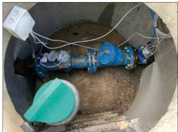
Aquasector CL: medida de cloro en línea para redes de agua potable.
