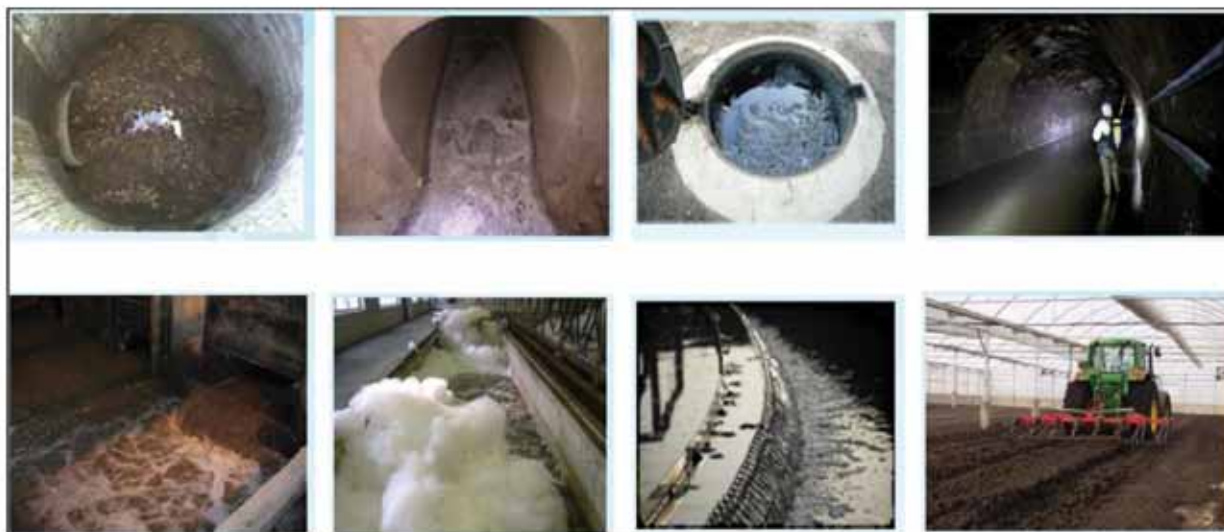
Figura 6. Posibles efectos negativos de los vertidos industriales sobre los saneamientos: arriba, efectos sobre colectores; debajo, efectos sobre las EDAR.
